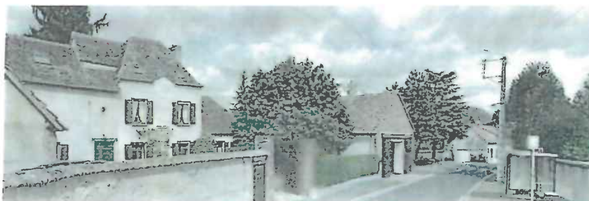
Rue de Beauce – bâti ancien
